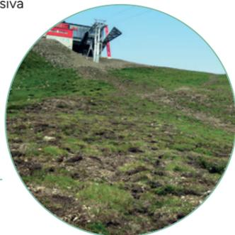
**Costruzione del pendio – ricoltivazione con zolle di terra** durante la costruzione del pendio come misura di mitigazione: la vegetazione esistente viene staccata in mattoni di vegetazione, le zolle di terra, e trapiantata. (Foto: Revital)
