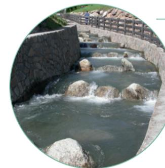
Le **scale di risalita** per i pesci sono un'importante misura di mitigazione per l'utilizzo dell'energia idroelettrica (presa d'acqua sull'Isarco). (Foto: Vito Adami)
