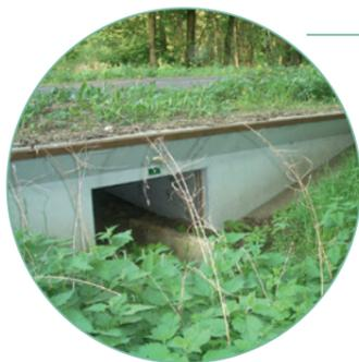
I **passaggi per anfibi** sono costituiti da barriere e dispositivi di guida paralleli alla strada e da tunnel sottopassaggio di attraversamento della strada. L'installazione successiva è molto costosa. I passaggi devono essere mantenuti aperti e controllati regolarmente. (Fonte: WikimediaCommons/Tegethof)
