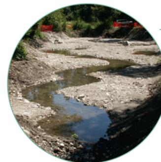
**Ripristino di un fosso sorgivo rettificato** tramite abbassamento del terreno e modellazione morfologica (Ontaneto della Rienza, Valdaora; fine della fase di costruzione, misura di compensazione). (Foto: Vito Adami)
