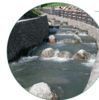
**Funktionsfähige Fischaufstiegshilfen** gehören zu den wichtigen Milderungsmaßnahmen der Wasserkraftnutzung (Wasserkraftnutzung am Eisack). (Foto: Vito Adami)
