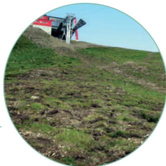
**Pistenbau – Rekultivierung mit Rasensoden** beim Pistenbau als Milderungsmaßnahme: Vorhandene Vegetation wird in Vegetationsziegeln, den Rasensoden, abgeschält und verpflanzt. (Foto: Revital)
