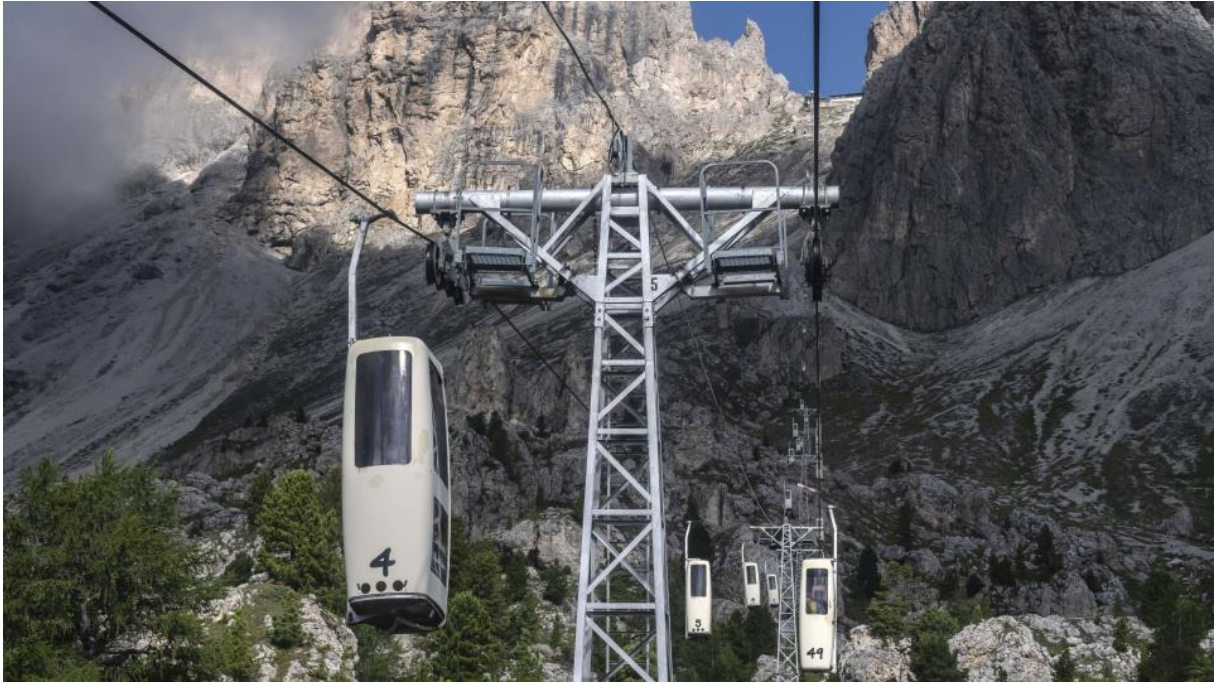
La funivia del Sassolungo: L'impianto, ormai obsoleto, si trova di fronte a un bivio (Foto: Othmar Seehauser)
