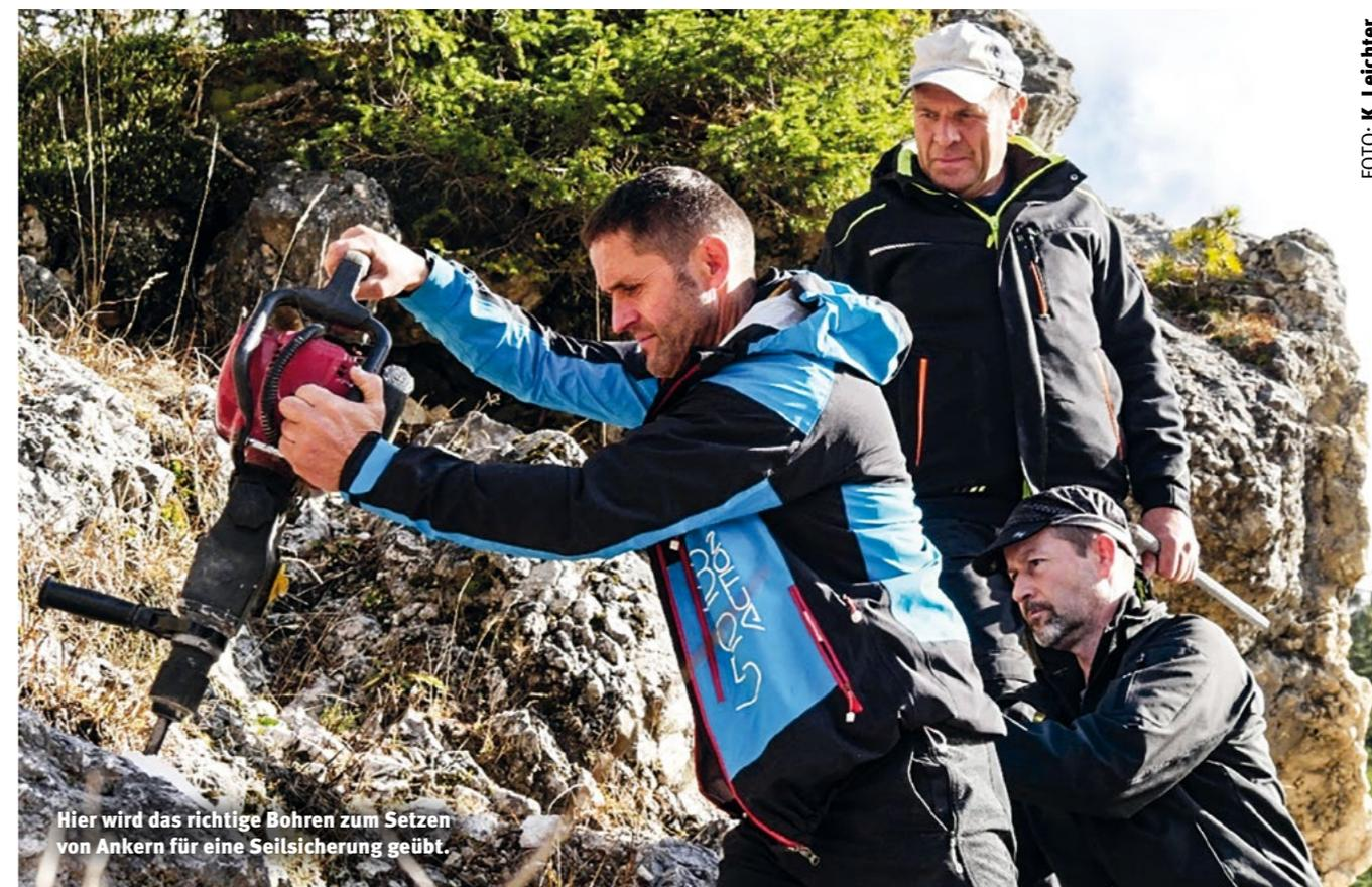
Hier wird das richtige Bohren zum Setzen von Anker für eine Seilsicherung geübt.
