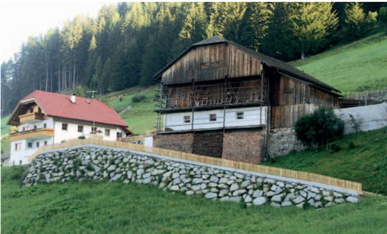
Neue Hofzufahrt in Tesselberg mit hohen Stützmauern, schönem alten Wirtschaftsgebäude und neuem „modernem“ Wohnhaus
