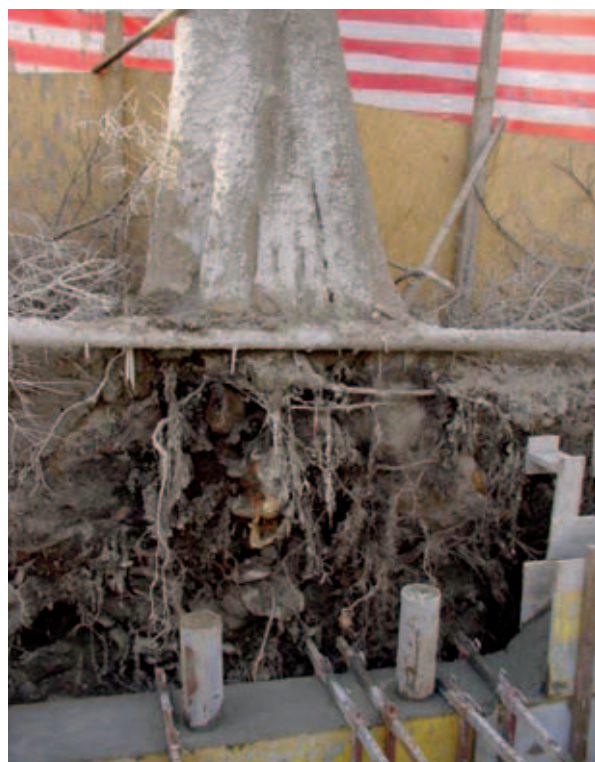
Baum in „arger Bedrängnis“ auf einer Baustelle
