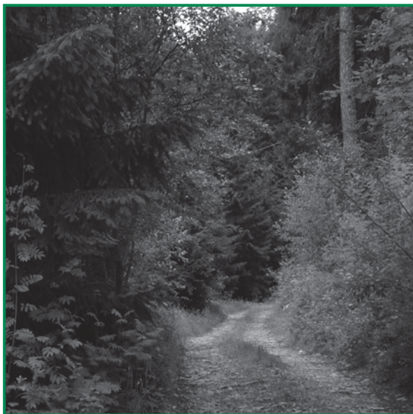
Errichtung eines Waldweges
