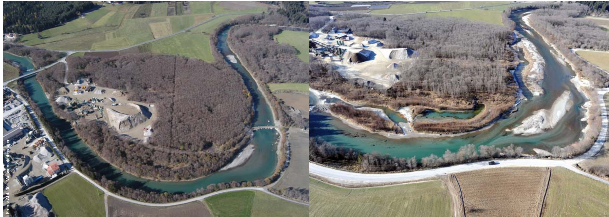
Abb. 5 und 6: Revitalisierung der Ahr im Bereich Gatzau bei Gais: vor der Revitalisierung 2003 (links) und nach Abschluss des 3. Bauabschnittes zur Revitalisierung 2011 (rechts)
