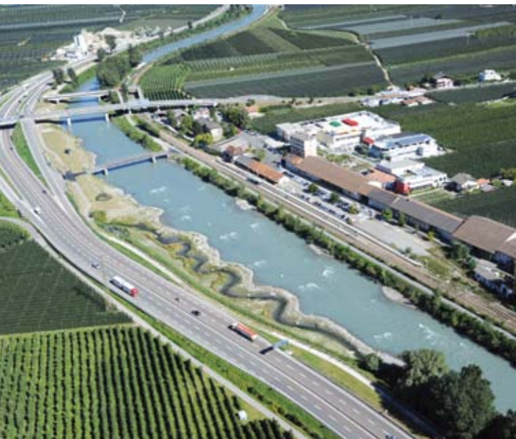
Abb. 4: Etsch bei Burgstall/Lana nach Bauabschluss 2012: Auflockerung der geraden Uferlinie, Flussbettstrukturierung durch Fischstörsteine und Anbindung des Kammergrabens an die Etsch
