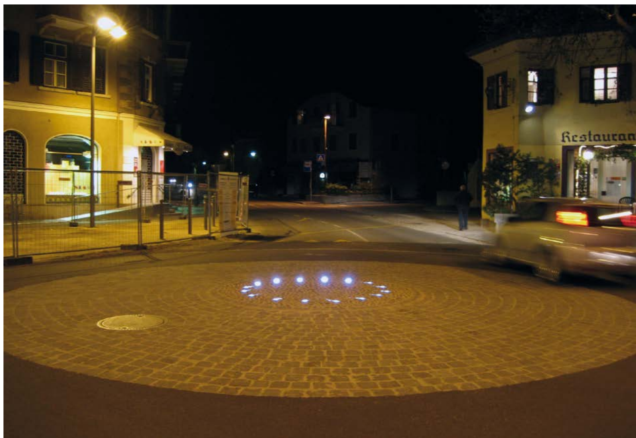
Abb. 8: Lana - Tribusplatz mit überfahrbarem Kreisverkehr samt Beleuchtung
