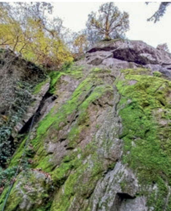
Moos auf den Felsen muss entfernt und die Felsen darunter müssen abgebürstet werden
