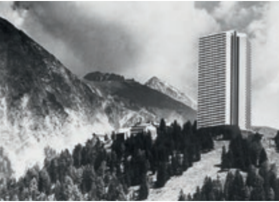
1 Eines der Projekte, gegen das die Regionale Naturschutzkommission protestierte, war das geplante Hotel-Hochhaus auf dem Piffinger Köpfl auf Meran 2000
