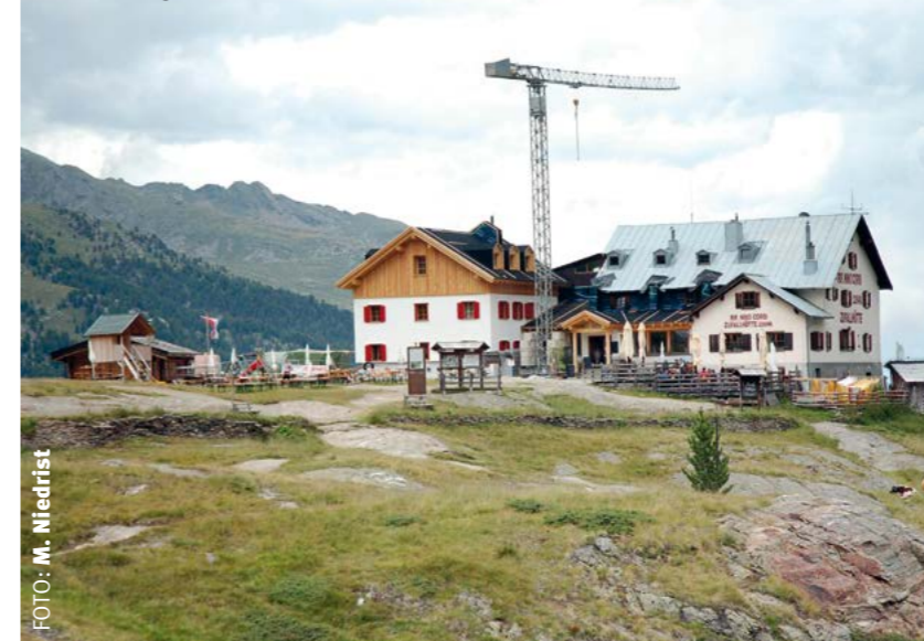
Die Zufallhütte während der Sanierungsarbeiten im Juli 2021
