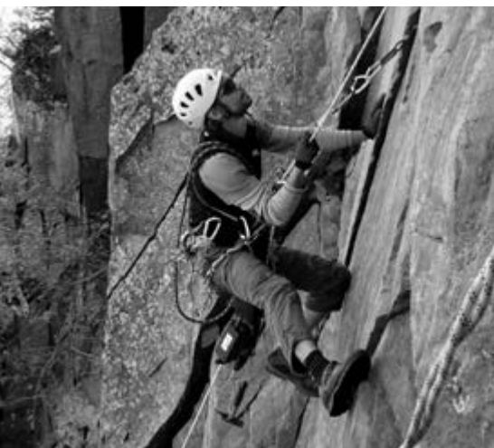
Die rund 150 Klettergärten in Südtirol müssen regelmäßig gewartet und auch saniert werden. Viele Arbeiten werden ehrenamtlich durch AVS-Sektionen erledigt.
