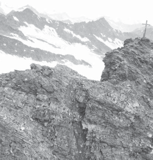
Durch den Felsausbruch unterhalb des Gipfels der Hohen Wilde musste der gesamte Gipfelanstieg auf den Südgrat verlegt werden
