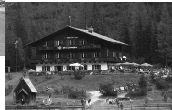
2011 wurde das Dach der Dreischusterhütte vollständig erneuert und neu eingedeckt
