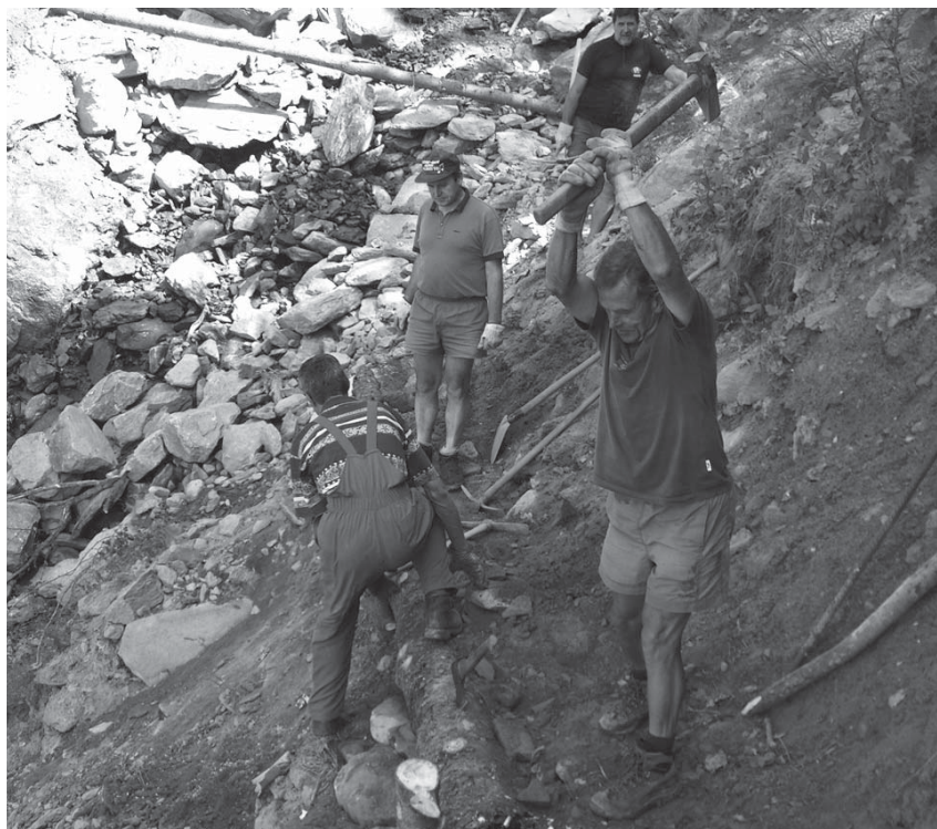
Instandhaltung am Weg zum Hochganghaus durch die Ortsstelle Algund
