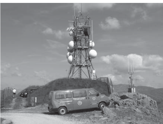
26 Umsetzer, wie hier am Ritten, sind Teil unseres Funknetzes
